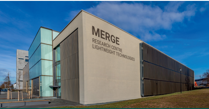
1 Das neue Laborgebäude am MERGE Research Centre „Lightweight Technologies“ grenzt unmittelbar an die bereits 2015 fertiggestellte MERGE-Forschungshalle.
